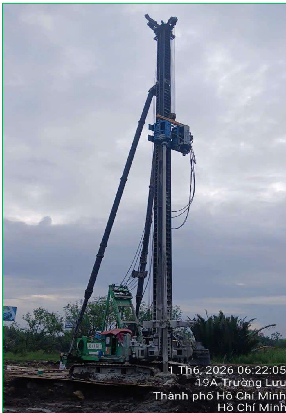
- Hình 4: MÁY KHOAN PD100 – TẠI GÓI THẦU XL01 ĐƯỜNG VÀNH ĐAI 3 (TP. THỦ ĐỨC).
