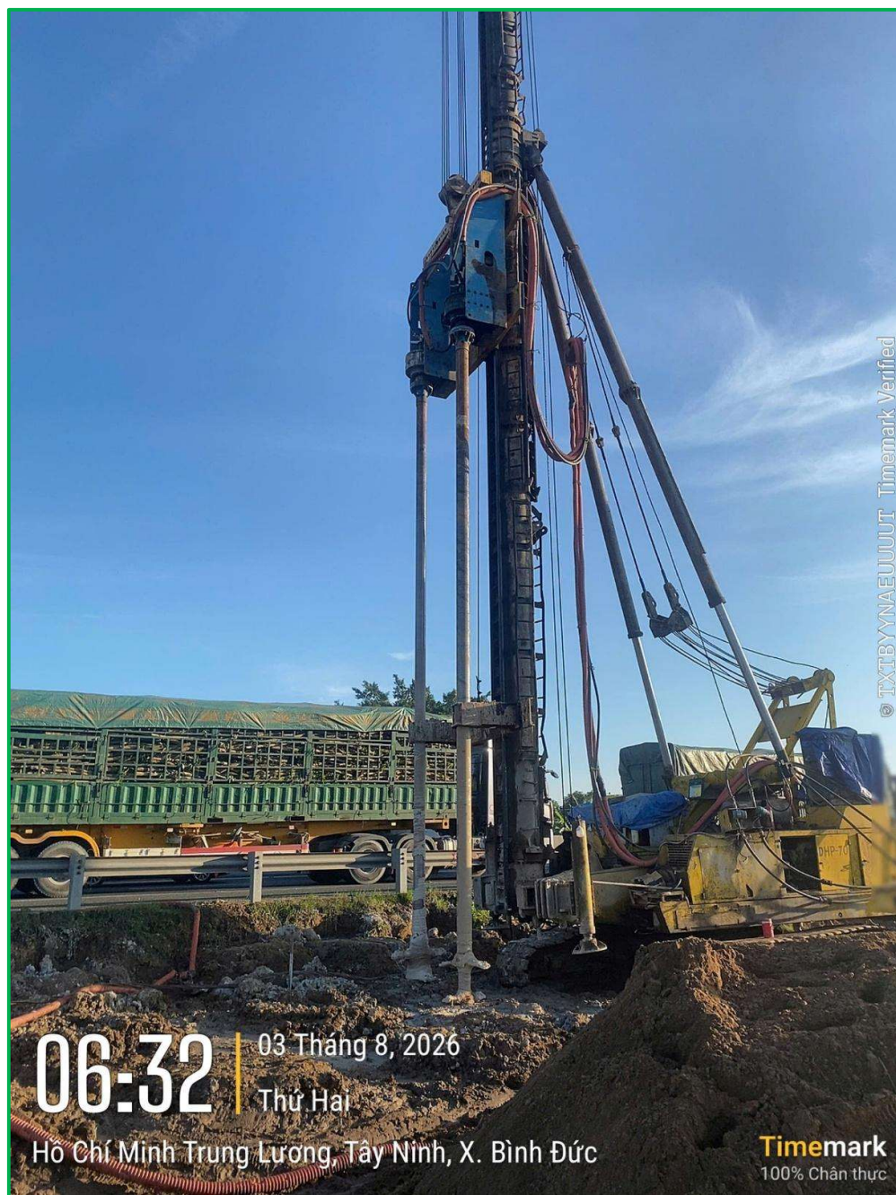
- Hình 6: MÁY KHOAN DHP70 – TẠI DỰ ÁN MỞ RỘNG CAO TỐC TP. HCM – TRUNG LƯƠNG – MỸ THUẬN.
