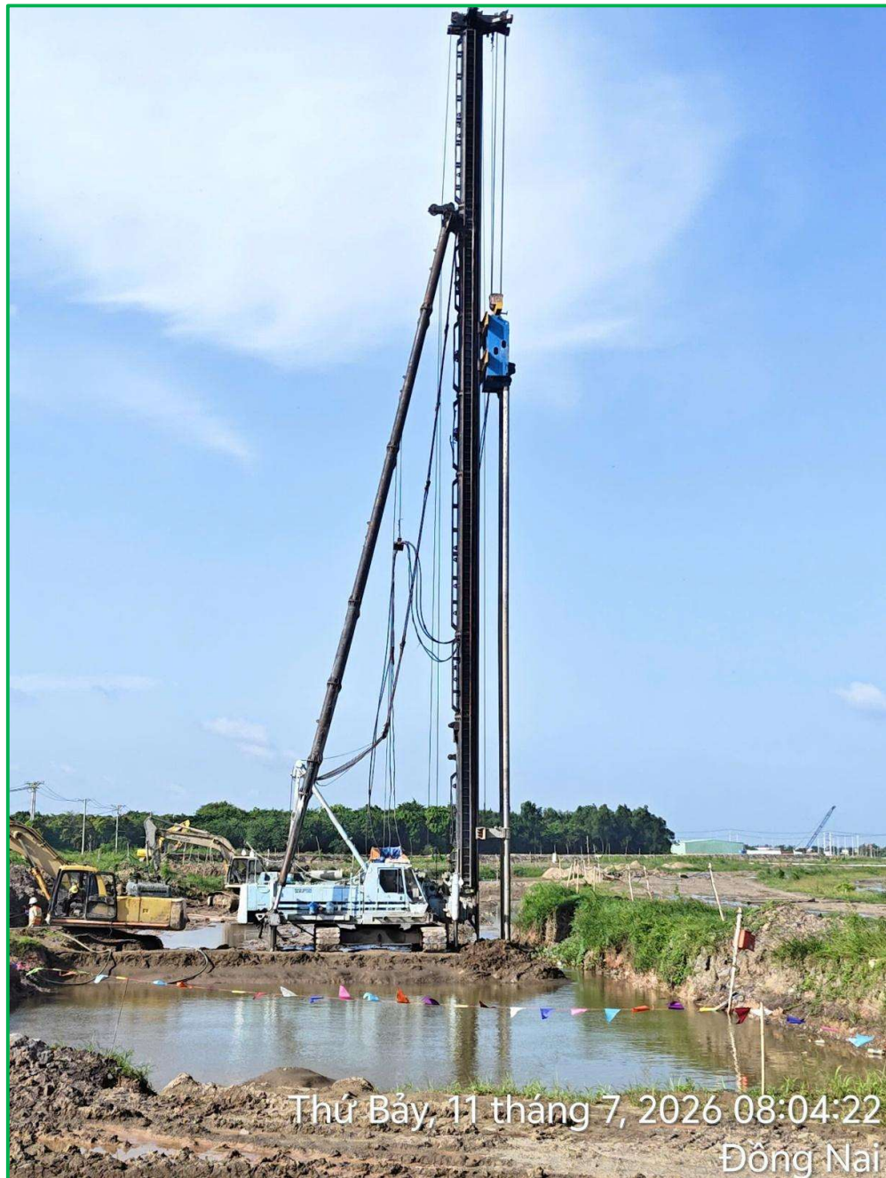
- Hình 1: MÁY KHOAN DH558 – TẠI DỰ ÁN AQUA CITY - CÙ LAO PHƯỚC HƯNG.
